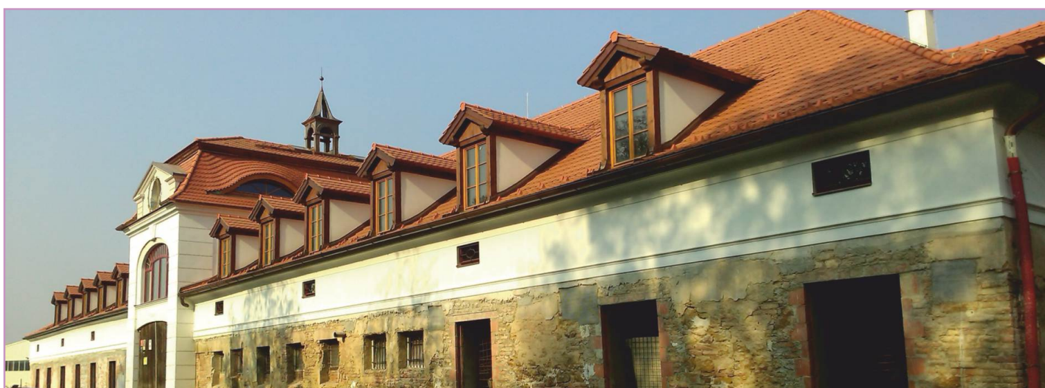
Realizace Česká republika. Obnova krovu usedlosti z 15. století, státem chráněná památka.
