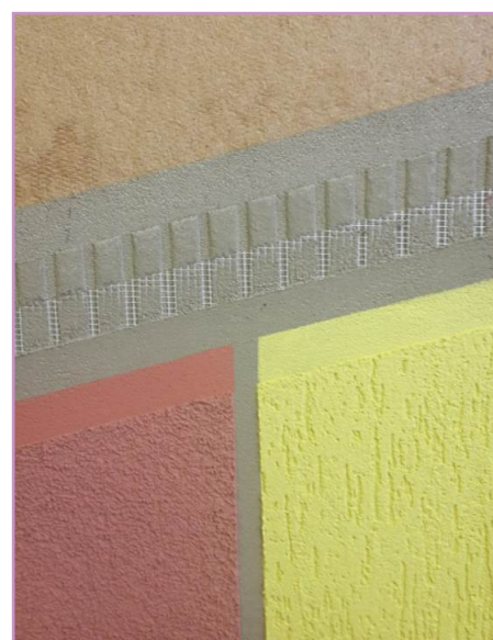
Omítkové souvrství na desce PAVATEX
