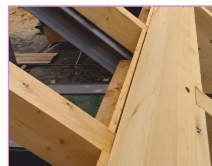
Zakládací hranol rovnoběžně s vnějším lícem zdiva
