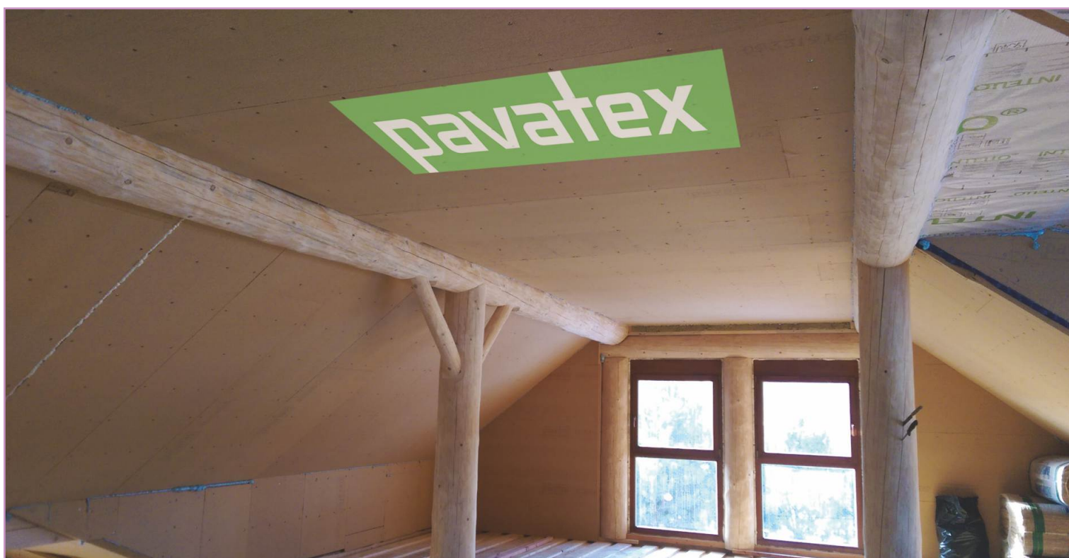
Zateplení podkroví srubu z interiéru, Isolair 60 mm
