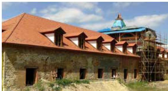
Obr. 14 - Pohled na severní stranu (06/2017)
