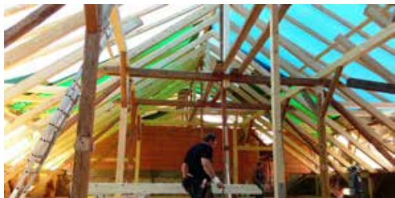
Obr. 7 - Nový krov s využitím některých původních prvků
