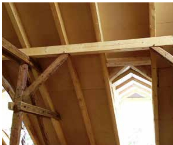
Obr. 10 - Zateplení při pohledu z interiéru (11/2016)
