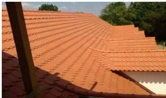
Obr. 12 - Tašková krytina na jižní straně (06/2017)
