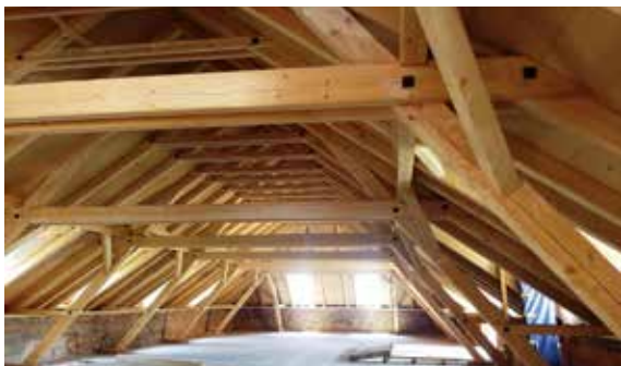
Obr. 11 - Pohled do interiéru pod střešou (06/2017)
