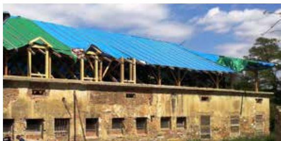
Obr. 8 - Zastřešení a první vikýře (08/2016)
