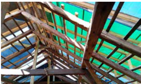
Obr. 3 - Původní krov, provizorní zastřešení (04/2016)
