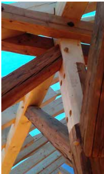
Obr. 5 - Detail spojení nových a starých trámů (09/2016)
