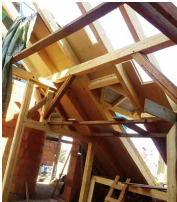
Obr. 9 - První desky Pavatex na střeše (09/2016)
