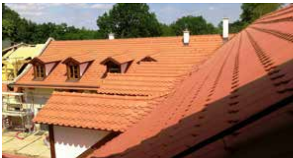
Obr. 13 - Jižní střeška směrem do dvora (06/2017)
