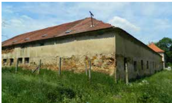
Obr. 19 - Jihovýchodní nároží dříve (archiv)
