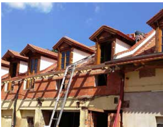
Obr. 15 - Rekonstrukce v roce 2017, II. etapa (09/2017)
