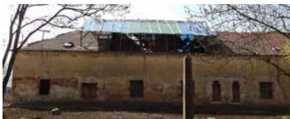
Obr. 2 - Částečně odkrytá střecha (04/2016)
