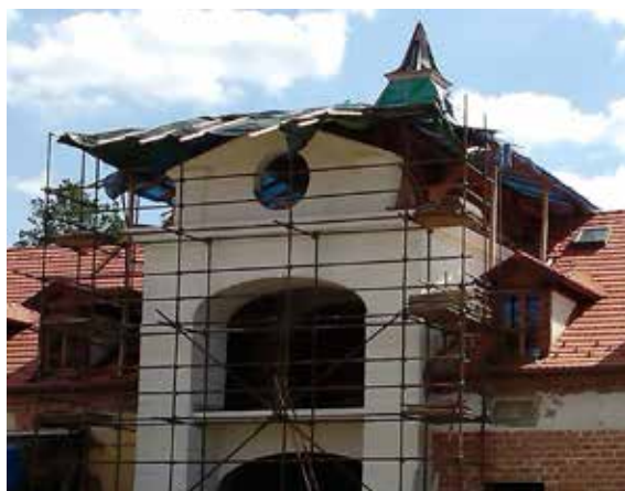
Obr. 16 - Nová výstavba, „věž“ (09/2017)
