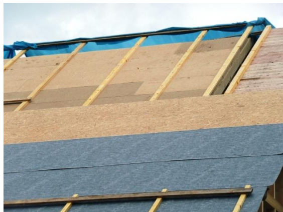
Obr. 12) Přesah střechy u štítu
