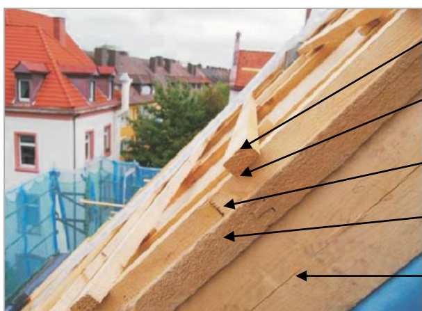
Obr 8) : Uspořádání materiálů s deskami PAVATEX nad krokviemi – praktická realizace.
