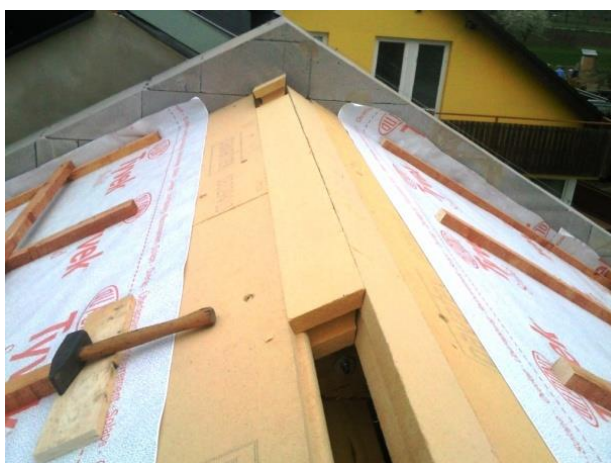
Obr. 9) Ukončení desek u hřebene
