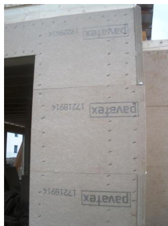
Obr. 9, 10: Úprava a sponkování desek kolem okenního otvoru a na nároží
