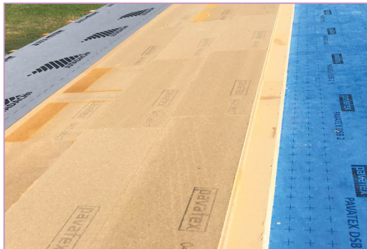
Pavatherm 120 + Isolair 120 = 240 mm
