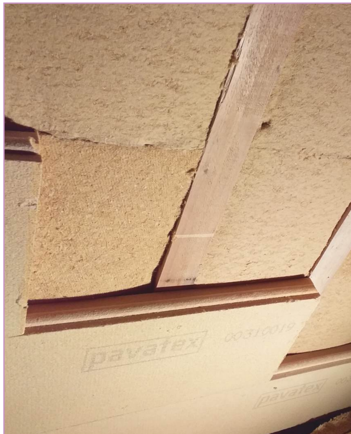
Střecha nad podkrovím, Combi 60 mm, Pavaflex 180 mm
