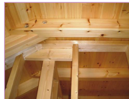
Pohledové krokve v interiéru
