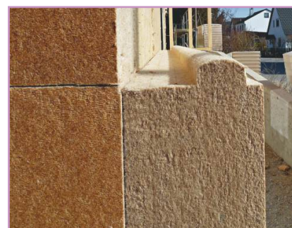
Detail ISOLAIR 100 mm na fasádě
