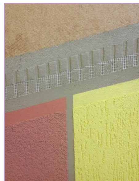
Omítkové souvrství na desce PAVATEX
