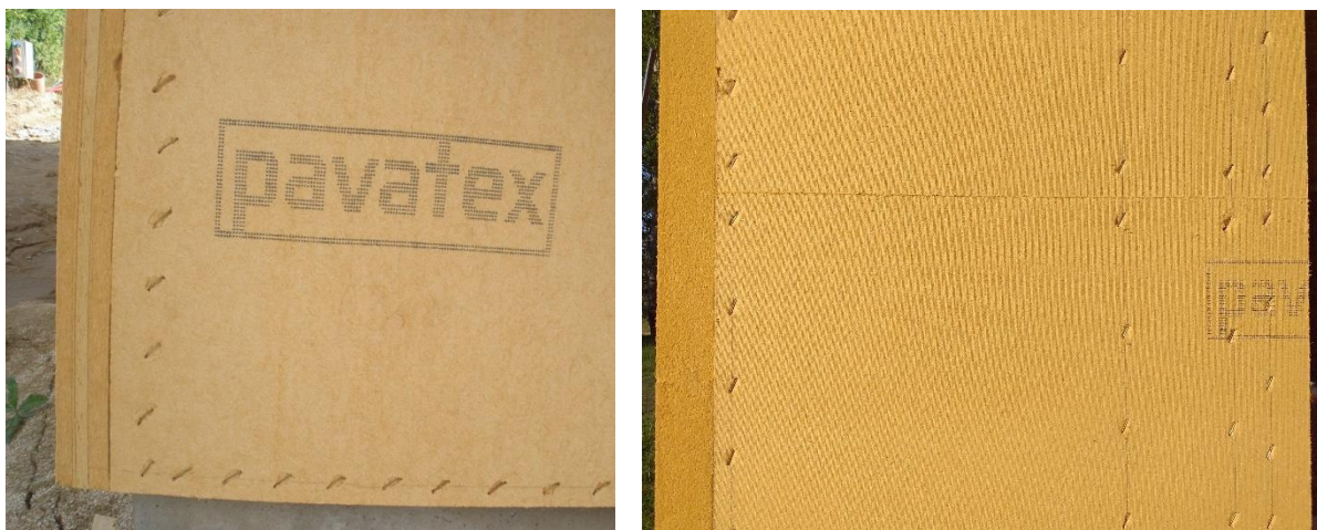
Obr. 9, 10: Úprava a sponkování desek na nároží a kolem okenního otvoru
