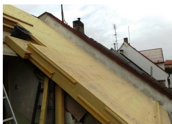
Foto 4, 5) Zateplená část střechy směrem do ulice. Detail v řezu, zřetelné jsou dvě desky tl. 120 mm položené na sobě
