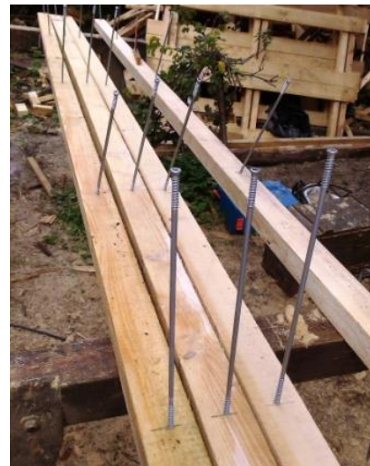
Obr. 3) schéma uspořádání šikmých vrutů Twin UD
