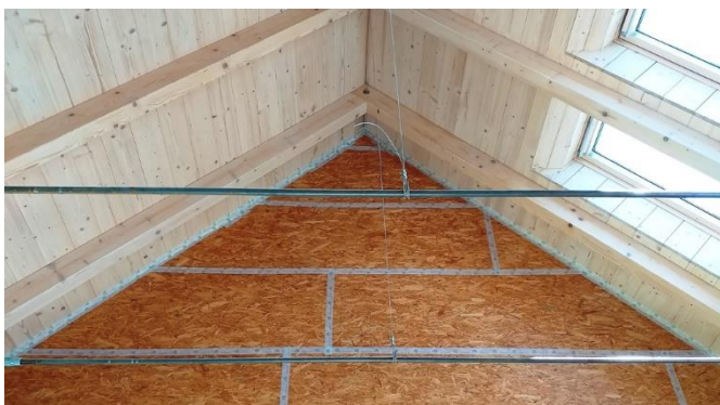
Foto 6, 7) Interiér a palubkový záklop s parobrzdnou vzduchotěsnou fólií Isocell
