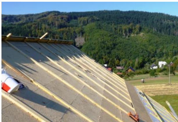
Obr. 11) Plošné zakrytí sedlové střechy
