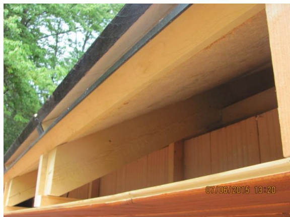
Obr. 7) Založení desky Pavatex u okapu
