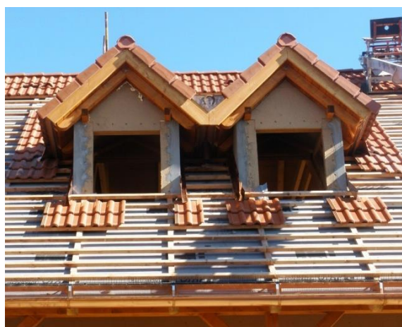
Obr. 10) Vnější zateplení vikýřů
