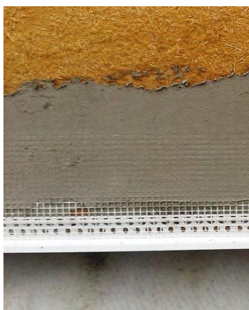
Obr. 3, 4: Zakládací lišta s okapničkou
