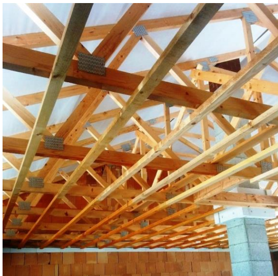
Obr. 4A, 4B : Laťový rošt v bungalovu. Více Poznámka 3.
