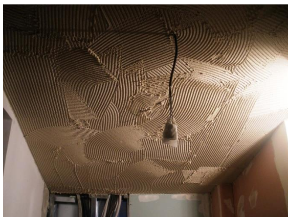
Obr. 7A, 7B : omítkové souvrství TERMO+ diffu, postup mokrý na suchý
