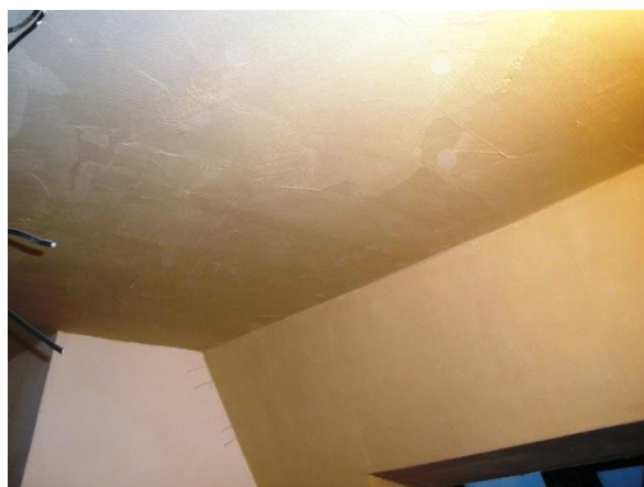
Obr. 7A, 7B : omítkové souvrství TERMO+ diffu, postup mokrý na suchý
