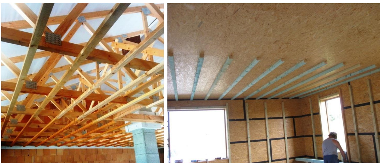
Obr. 5A, 5B : Laťový rošt v bungalovu. Více Poznámka 3.
