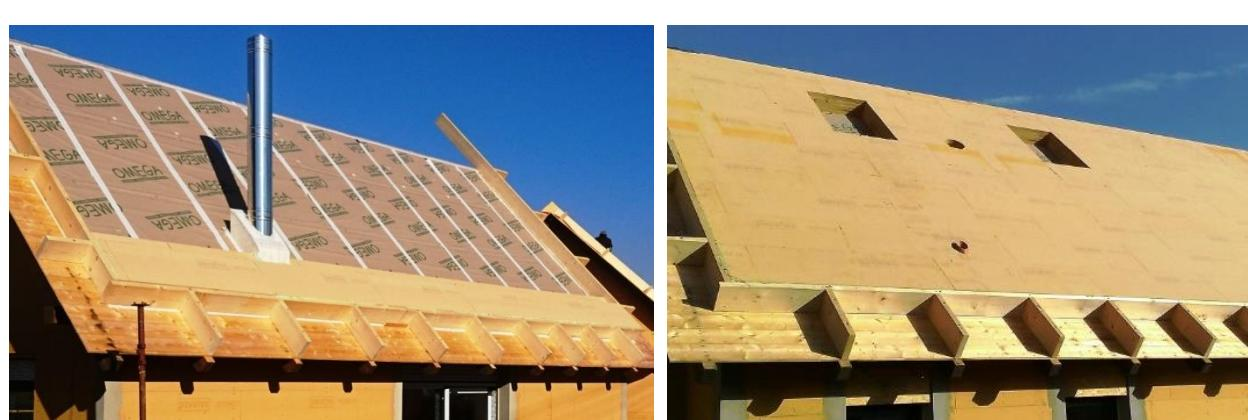
**Zděná novostavba** s Pavatexem nad krovkami. Vzduchotěsná fólie PAVATEX DSB2 společně s deskami PAVATHERM 120 mm + PAVATHERM-COMBI 100 mm tvoří kompletní souvrství nad obytným podkovovým zemědělského stavení.
