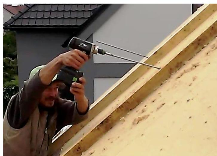
**Foto 2, 3)** Staveništění příprava vrutů Twin UD 440 mm do kontralatí a jejich šroubování na střeše
