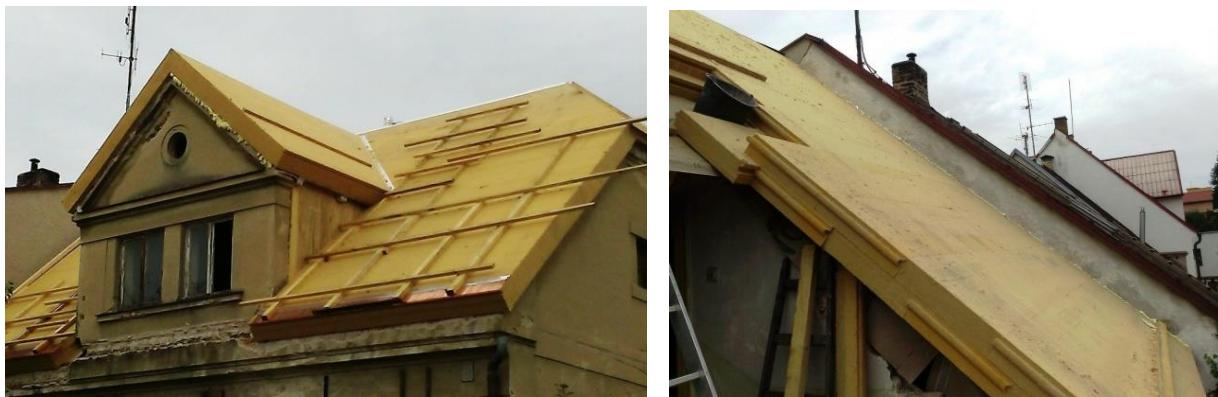
**Střešní plášt' dřevostavby**, která má izolační materiály Pavatex nejen na střeše, ale i v obvodovém pláště a v příčkách. Poměrně velká vzdálenost krovkí 115 cm a nadmořská výška s větším sněhovým zatížením vyžaduje použití desek Isolair 2 x 120 mm, které mají lepší pevnostní charakteristiky.
