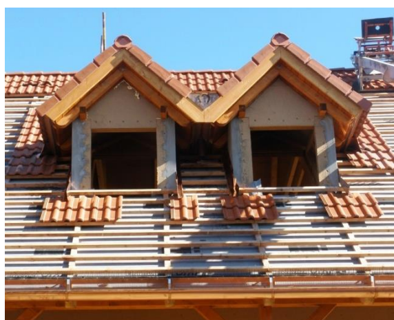
Obr. 12) Vnější zateplení vikýřů
