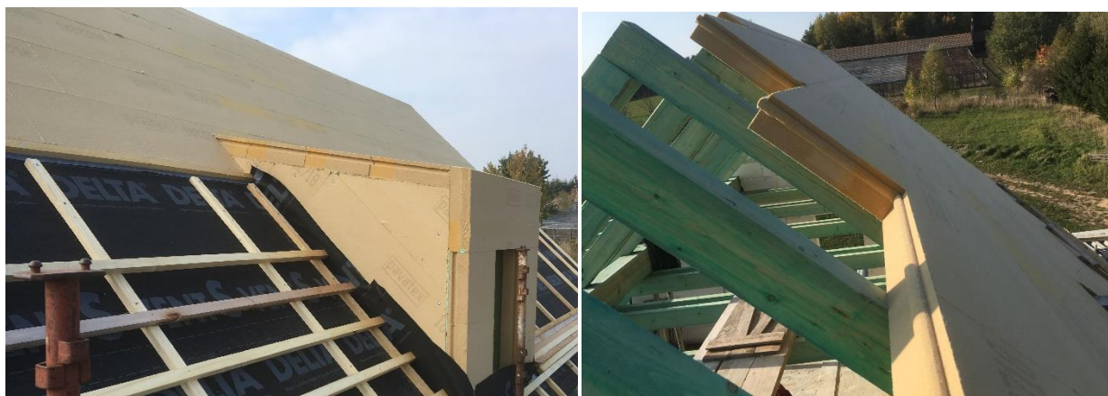
Obr. 2), 3): Obložení vikýře a uložení desky Isolair 140 mm na krokvích
