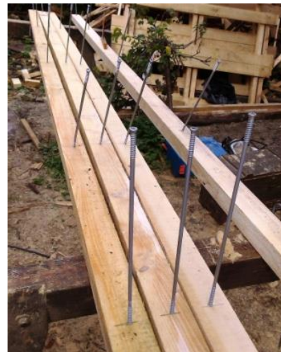
Obr. 3) schéma uspořádání šikmých vrutů Twin UD
