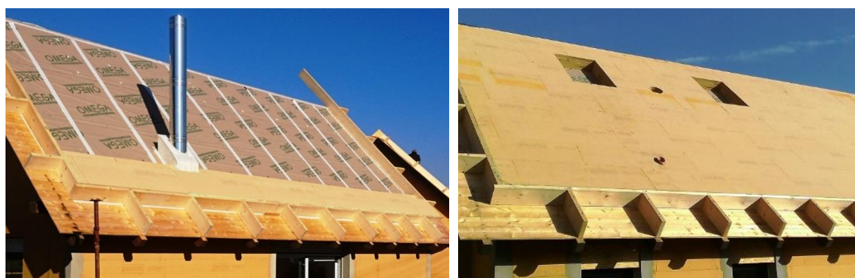
Foto 8, 9) Dřevovláknité desky ISOLAIR 2 x 120 = 240 mm
