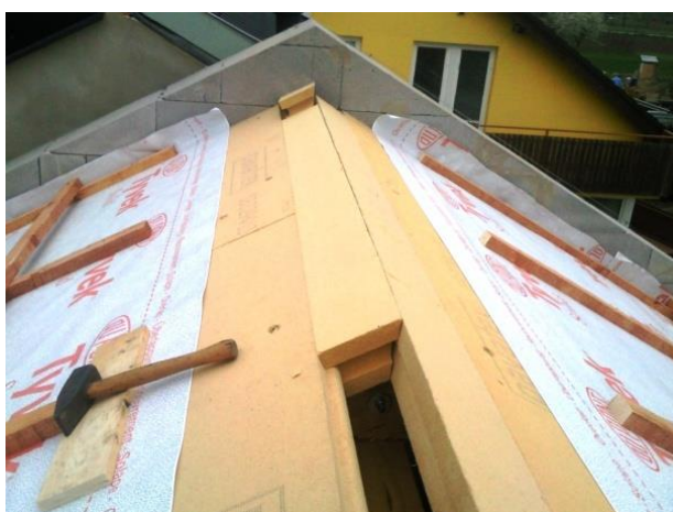
Obr. 11) Ukončení desek u hřebene
