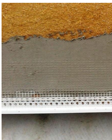
Obr. 3, 4: Zakládací lišta s okapničkou
