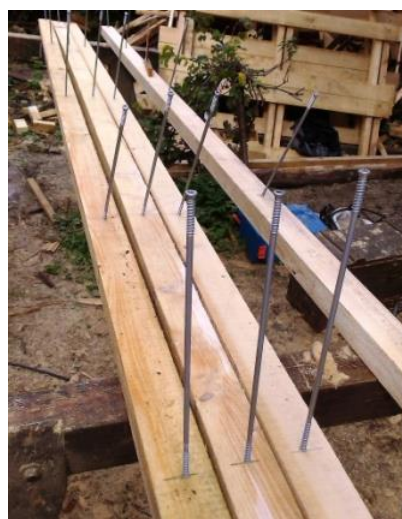
Obr. 3) schéma uspořádání šikmých vrutů Twin UD
