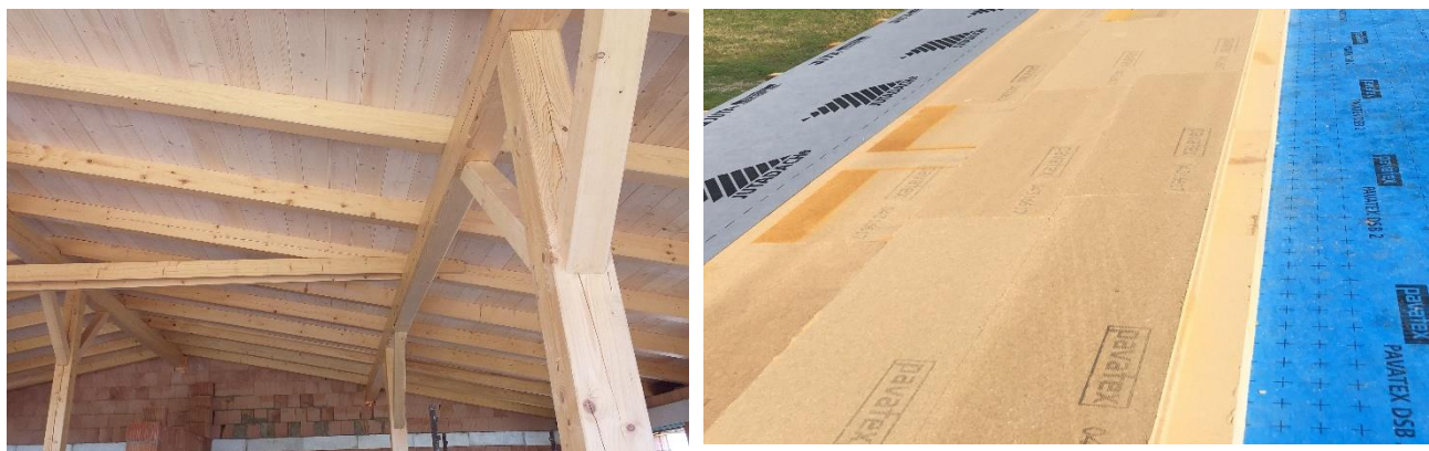
Foto 10, 11) Dřevovláknité desky PAVATHERM 120 mm + ISOLAIR 100 = 220 mm. Vzduchotěsná parobrzděná fólie PAVATEX DSB 2
