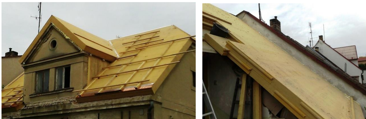
Foto 4, 5) Zateplená část střechy směrem do ulice. Detail v řezu, zřetelné jsou dvě desky tl. 120 mm položené na sobě
