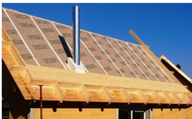
Foto 8, 9) Dřevovláknité desky ISOLAIR 2 x 120 = 240 mm
