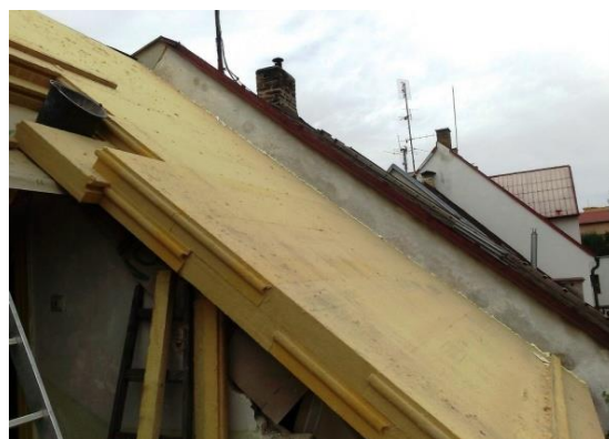
Foto 4, 5) Zateplená část střechy směrem do ulice. Detail v řezu, zřetelné jsou dvě desky tl. 120 mm položené na sobě
