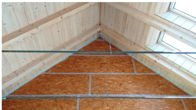
Foto 6, 7) Interiér a palubkový záklop s parobrzdnou vzduchotěsnou fólií Isocell
